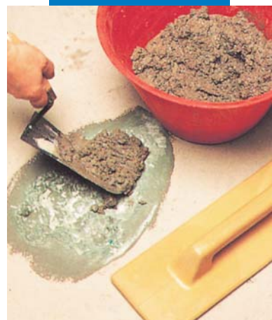
Reparación de un pavimento: aplicación del mortero
