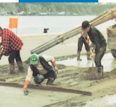
Recocado cementoso exterior aditivado con Planicrete. Obra Vieux Port, Québec, Canadá
