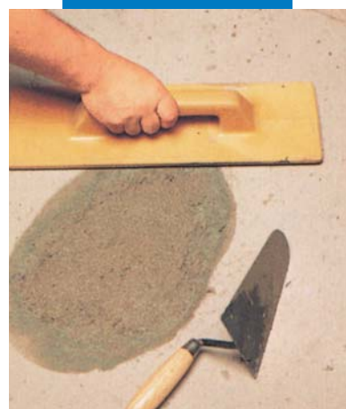
Reparación de un pavimento: fratasado final
