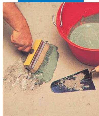
Reparación de un pavimento: aplicación de la lechada
