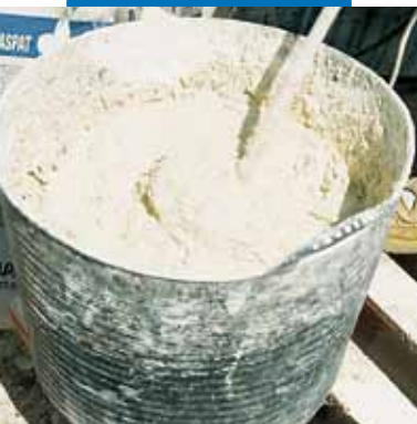
Amasado mecánico de Mapefront Raspat
