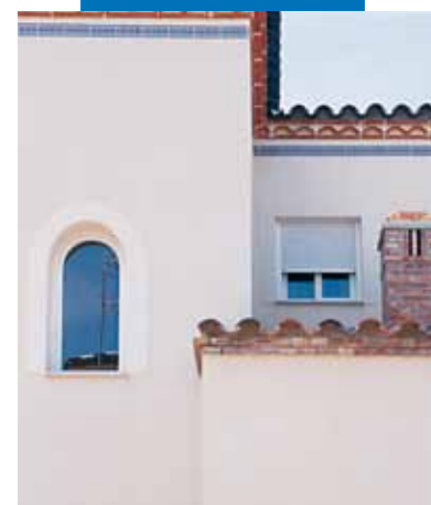
Fachada con Mapefront Raspat
