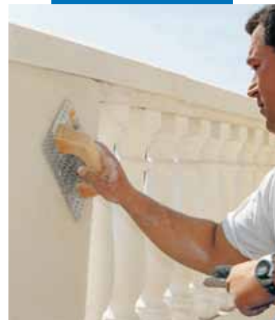
Raspado del material con llana de púas
